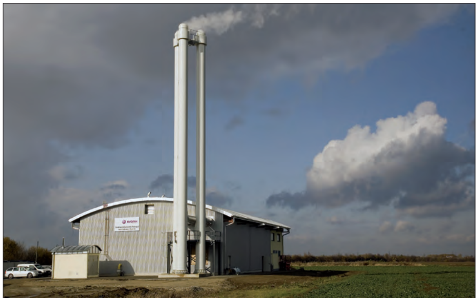
Das Geoheizwerk II in Erding
