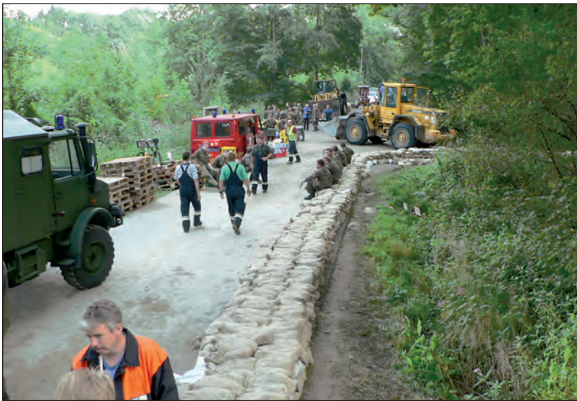
Einsatzkräfte bei der Absicherung des Damms
