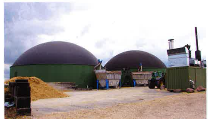
Abb. 2: Landwirtschaftliche Biogasanlage mit zwei Fermentern und Blockheizkraftwerk; das Problematerial stammt aus dem linken Fermenter
