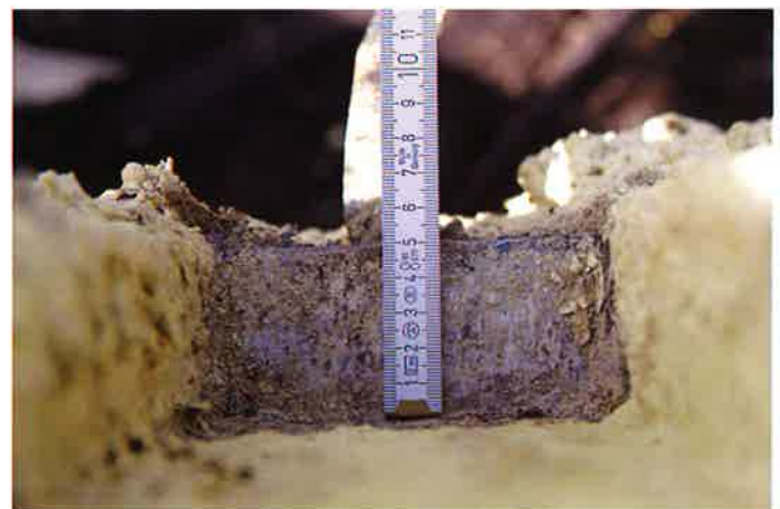
Abb. 10: Auflagetaschen für die Sparren am Behälterrand
