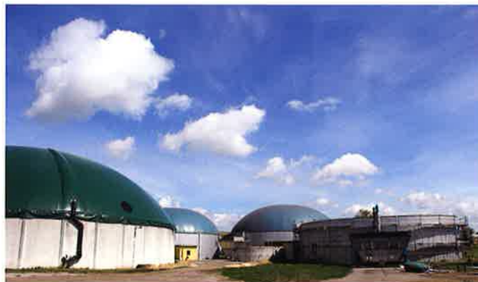
Abb. 1: Ansicht der untersuchten Biogasanlage, vorn rechts der geschädigte Fermenter nach Rückbau des Dachs
