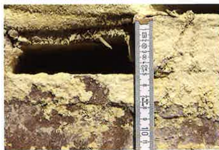
Abb. 5: Ansicht einer Sparrenauflage im Behälterrand
