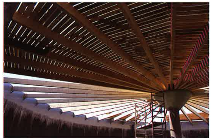
Abb. 5: Holzdecke Innenansicht auf Balken und Schalungsbretter eines baugleichen Fermenters
