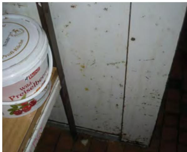
Verschimmelte Kühlzellenwand in einem Lokal
