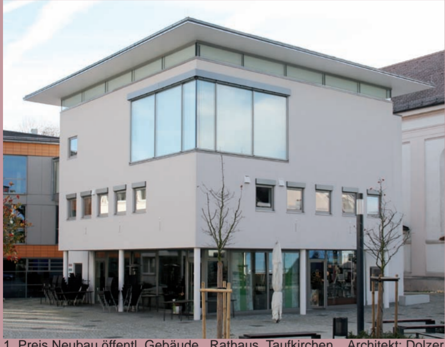
1. Preis Neubau öffentl. Gebäude Rathaus, Taufkirchen Architekt: Dolzer
