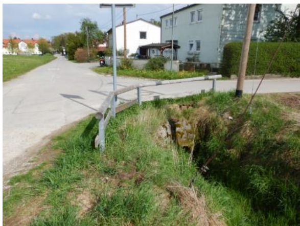
Abbildung 6: Einlauf des Wiesengraben in die Siedlungsverrohrung (Waldstrasse; BCE 05/2022)
