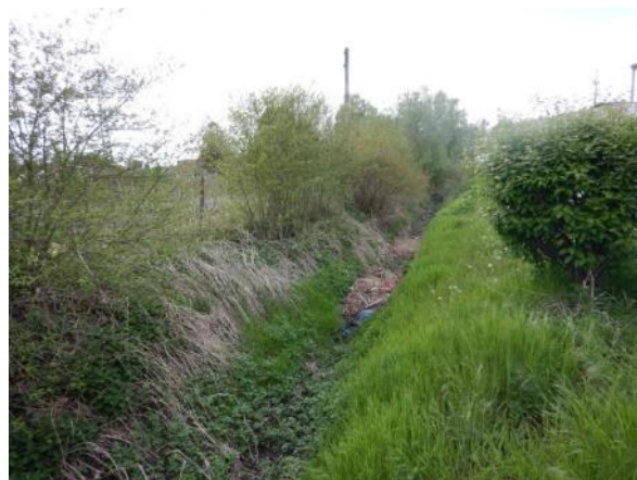
Abbildung 7: Aufhauser Graben unterstrom der Bahntrasse (BCE 05/2022)
