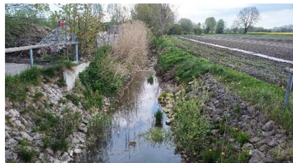
Abbildung 25: Moosgraben nach Verrohrung Pretzener Straße (Blick stromabwärts – BCE 05/2022)
