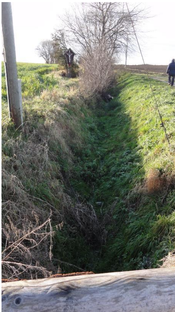
Abbildung 20: Wiesengraben oberstrom der pot. Stauffläche (Blick stromaufwärts – BCE 11/2017)
